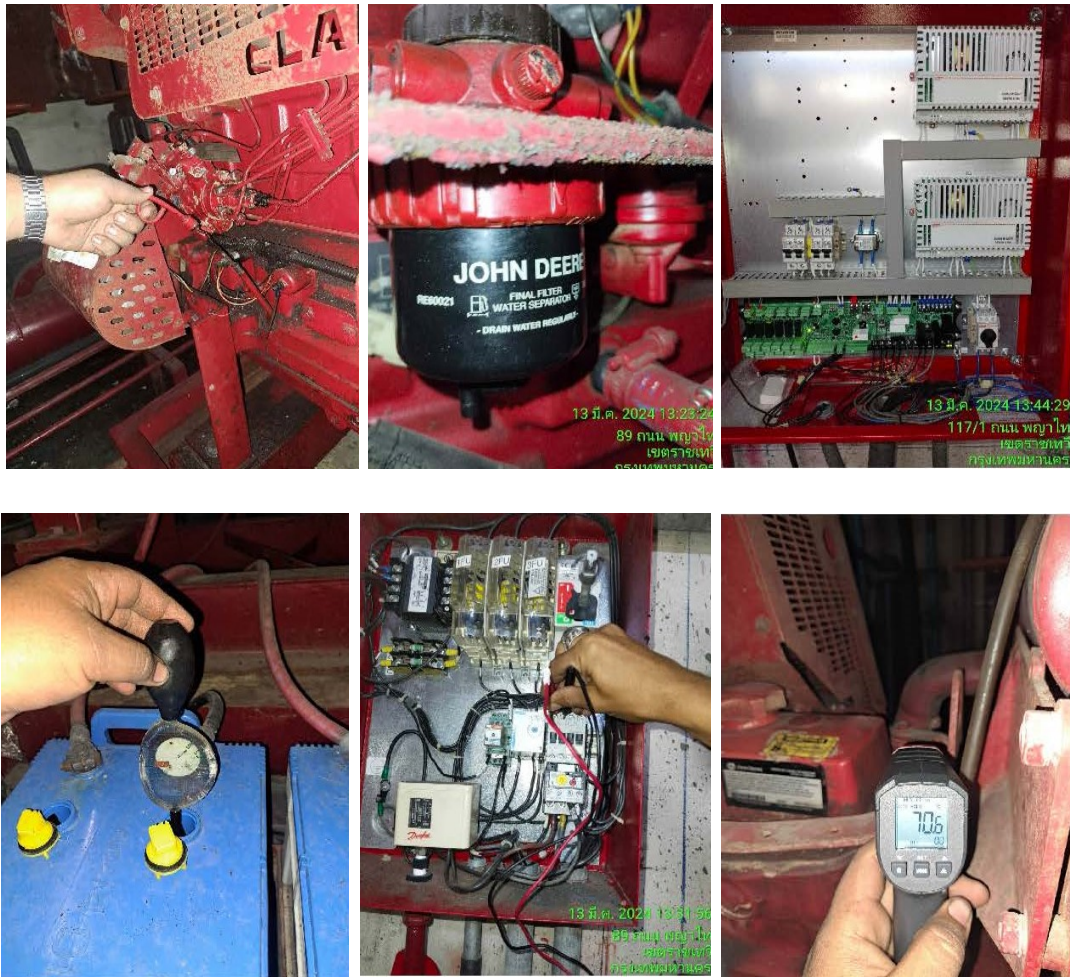
ภาพที่ 4-37 ตรวจสอบซ่อมบำรุงระบบ Fire Pump
