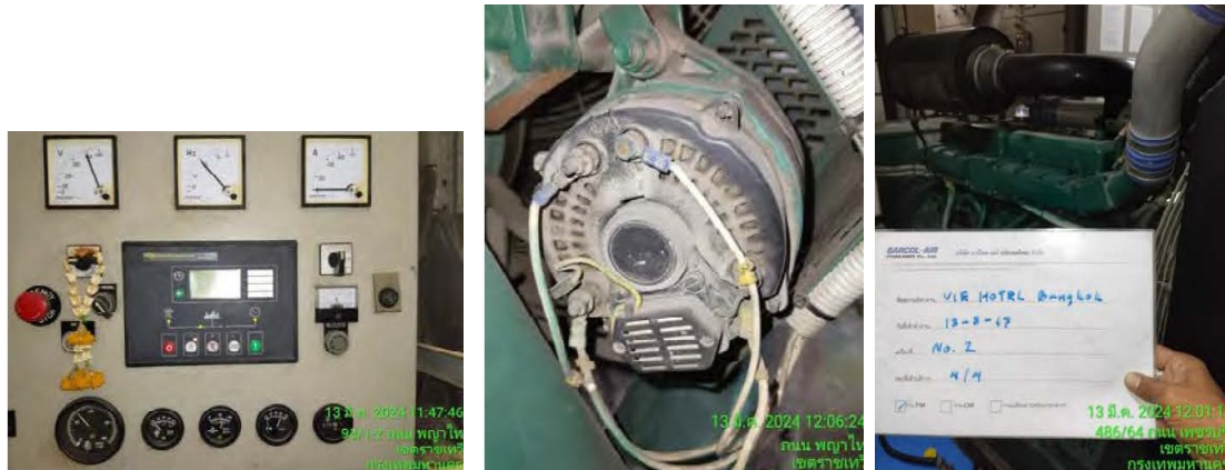
ภาพที่ 4-38 ตรวจสอบซ่อมบำรุงระบบ Generator (ต่อ)
